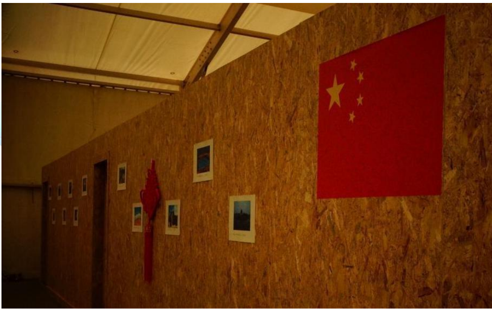
（图为采用可循环利用的环保墙体材料搭建的中国角）
